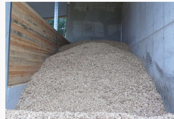
Holzhackschnitzelbunker mit Schubboden
