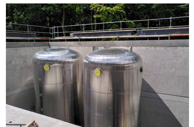
Aufstellung der Pufferpeicher im neuen Heizhaus Foto: get|2energy
