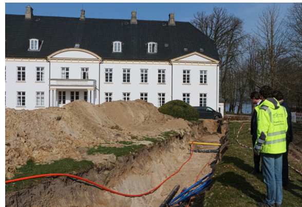
Verlegung der Fernwärmeleitungen im Schlossgarten Foto: get|2energy
