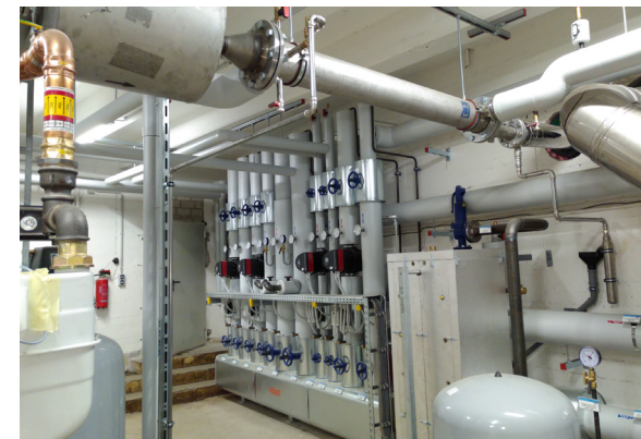
Heizungsverteiler | Quelle: Stadtwerke Kiel AG
