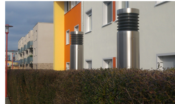
Abluft RLT-Anlage Haus 42 Quelle: E1 Energiemanagement GmbH
