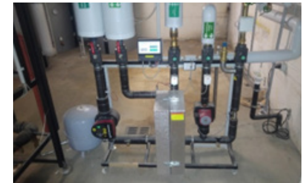
Frischwasserstation nach der Sanierung Quelle: E1 Energiemanagement GmbH
